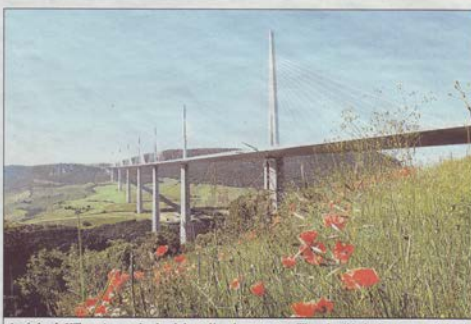
Le viaduc de Millau est en service depuis le 16 décembre 2004. 20 millions de véhicules l'ont emprunté depuis.
