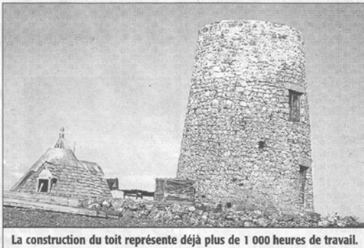
La construction du toit représente déjà plus de 1 000 heures de travail.
