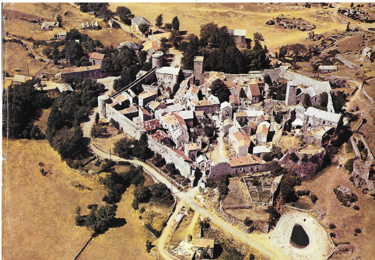
Archive fig. 30 : Vue aérienne de la commune. Carte postale, cliché réalisé vers 1968-69. Archive privée.
