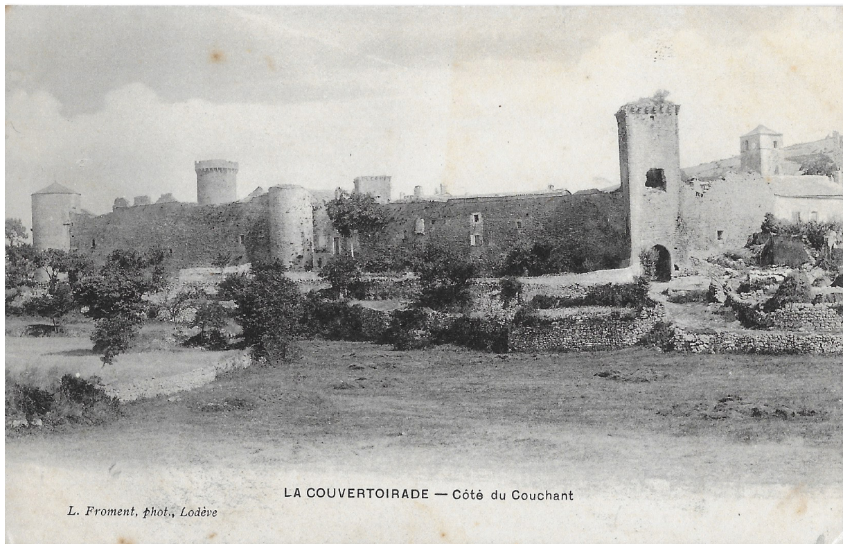
Archive fig. 7 : Vue de la commune, notamment de la face Sud de la porte d'Abal. Carte postale, cliché réalisé entre 1890 et 1912. Archive privée.
