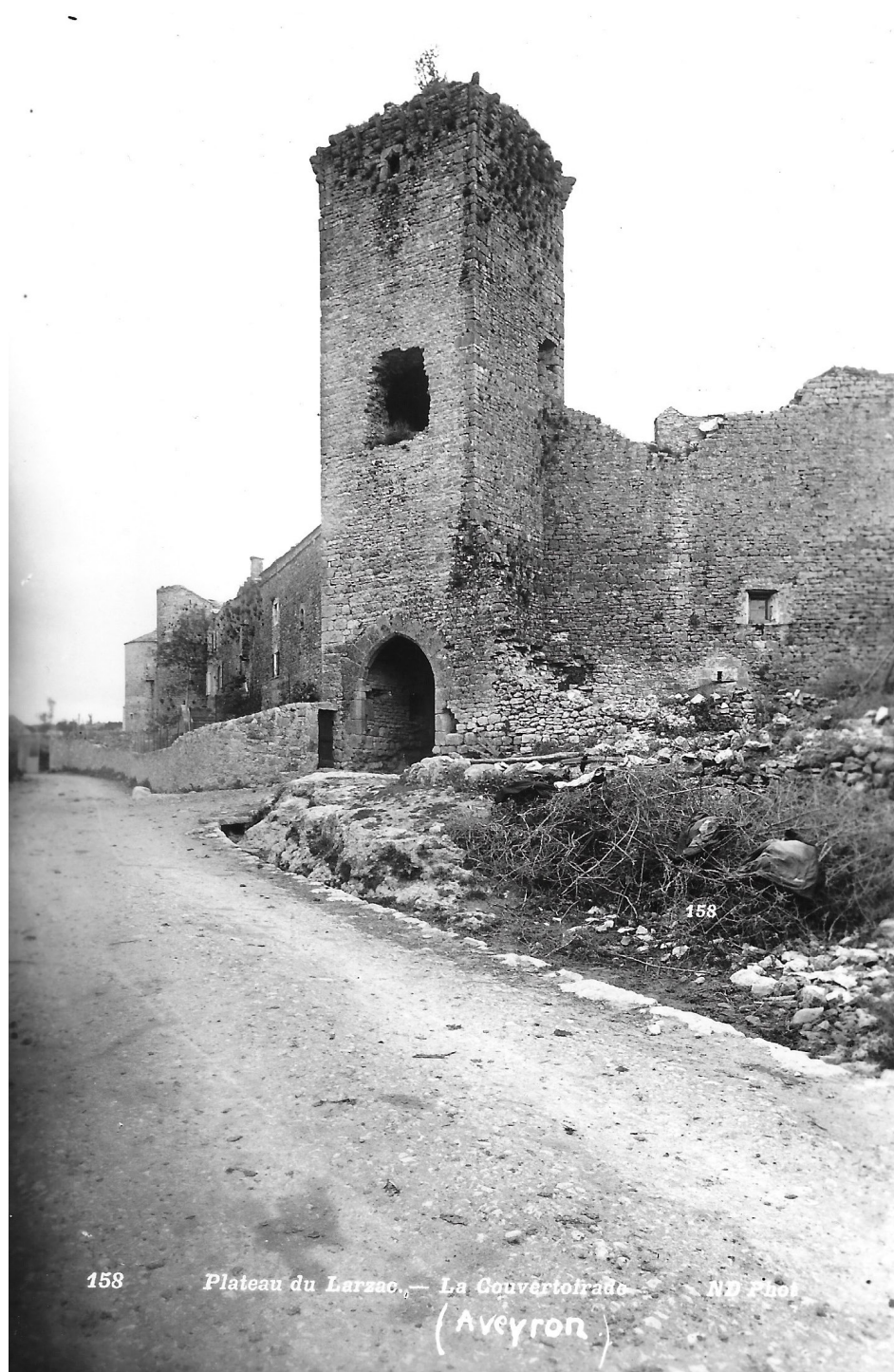
Archive fig. 12 : Vue des faces Sud et Est de la porte d'Abal. Photographie, vers 1890. Archive privée.
