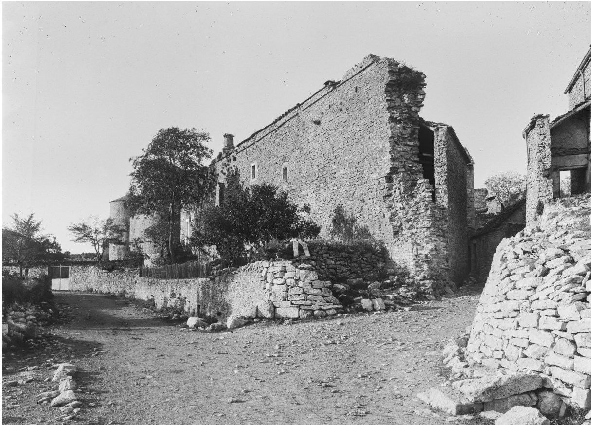
Archive fig. 15 : Vue de la porte d'Abal après effondrement. Photographie, cliché de Georges Estève réalisé entre 1912 et 1941. MPP - côte D/1/12/6-3 - MH0085948.
