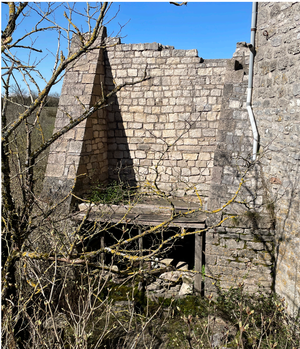
Fig. 8 : Vue de l'élévation est. Présence d'une construction en bois formant auvent.
