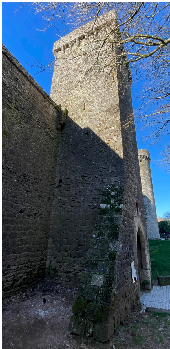
Fig. 27 : Vue de l'élévation est.
