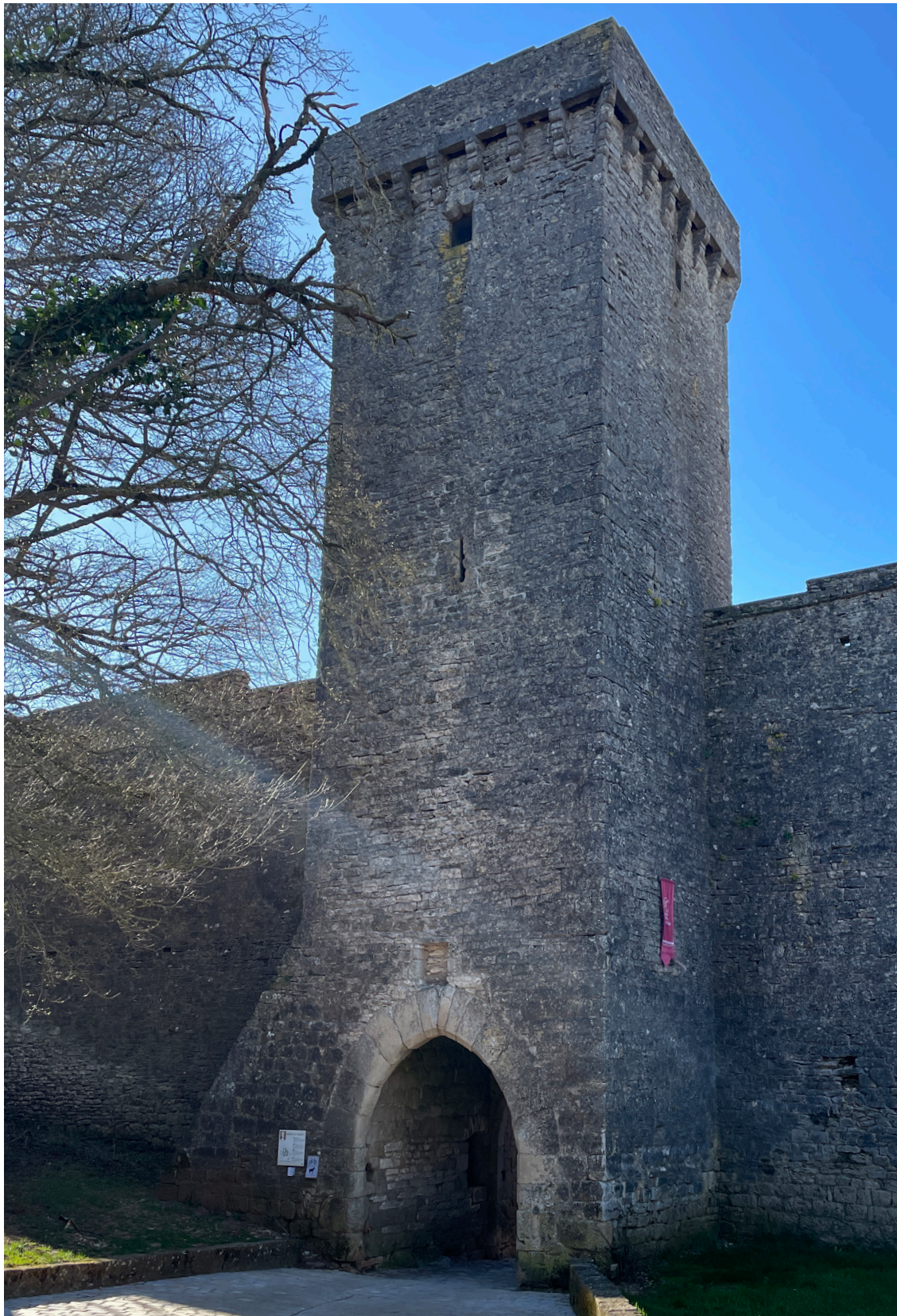
Fig. 25 : Vue de l'élévation nord.
