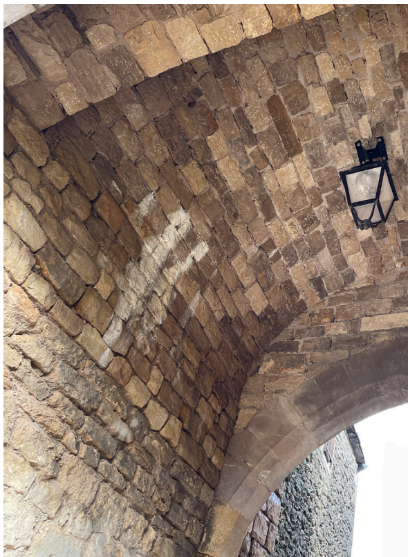
Fig. 21 : Encroûtement de calcite en partie supérieure.
