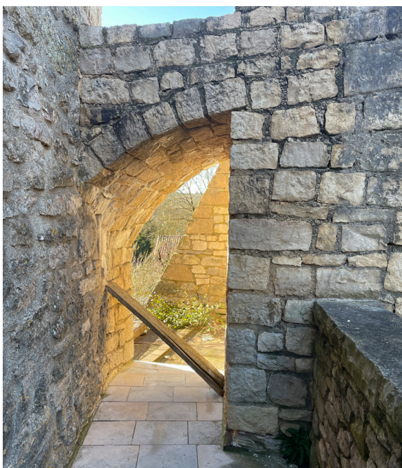
Fig. 6 : Vue du passage formant un arc-boutant à l'est de la tour.
