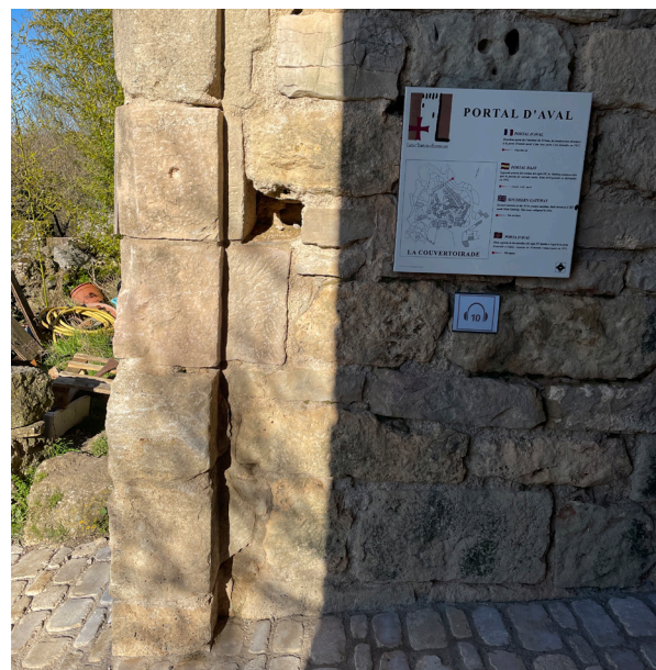
Fig. 17 : Vue du logement de la barre de clôture du portail.
