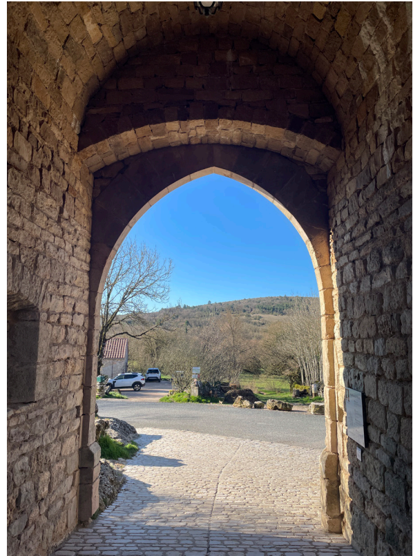
Fig. 19 : Vue de l'élévation intérieure, au revers de la face sud.
