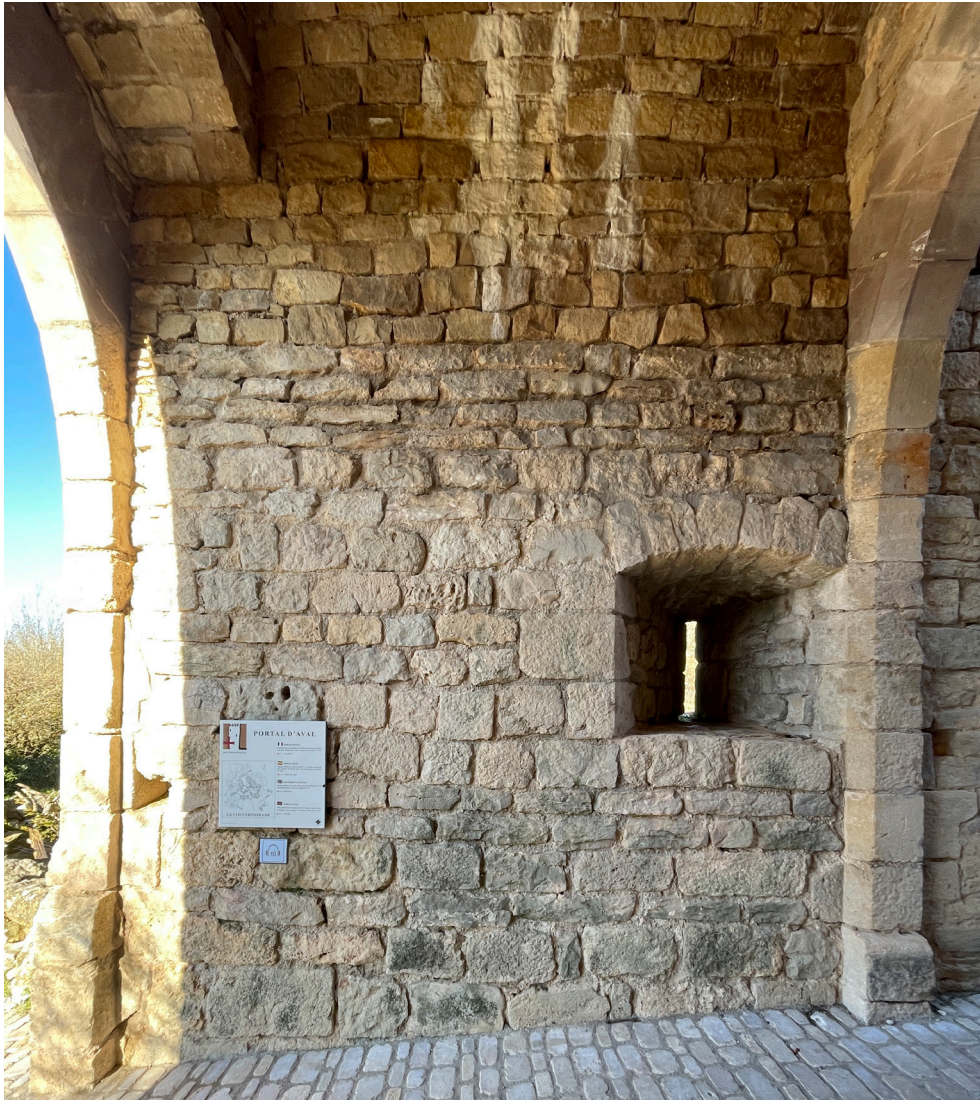
Fig. 15 : Vue de l'élévation intérieure, au revers de la face ouest. Présence d'un encroûtement de calcite en partie supérieure.
