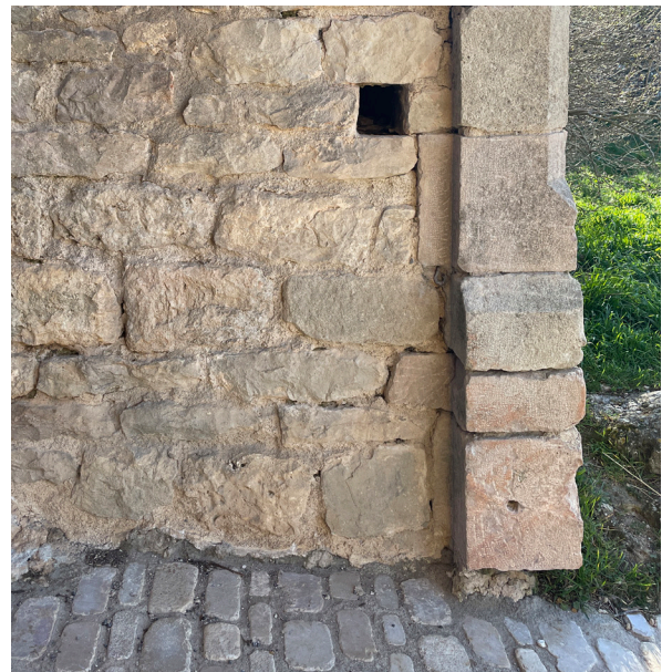
Fig. 14 : Vue du logement de la barre de clôture du portail.
