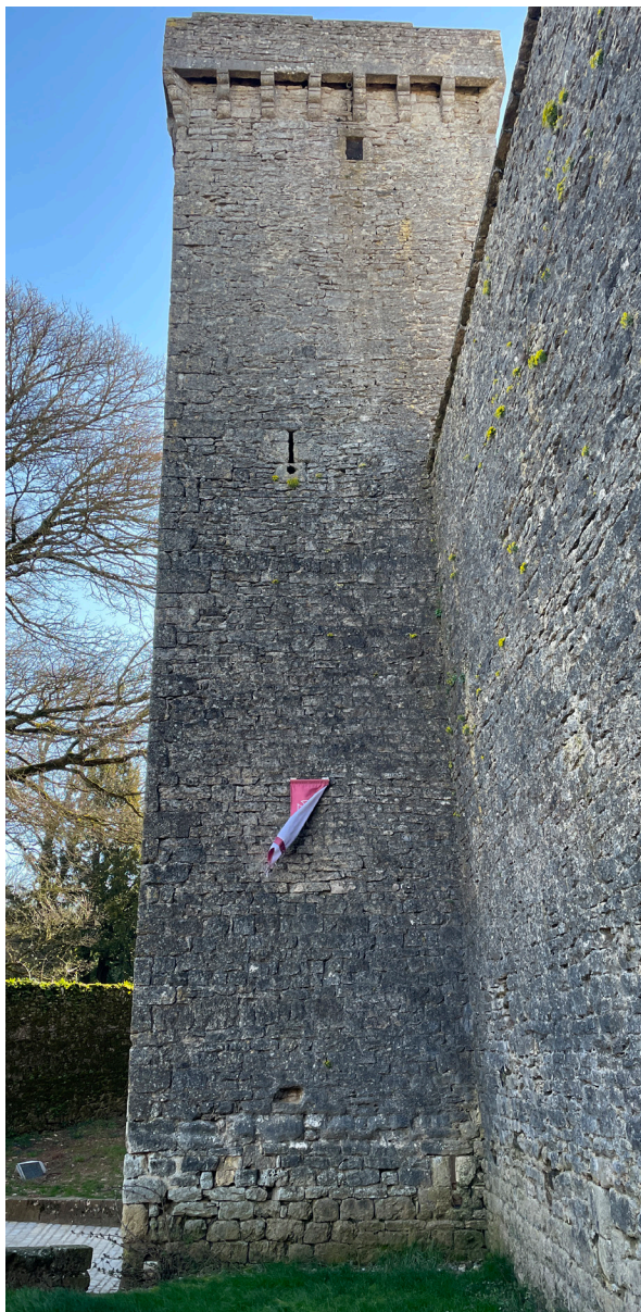
Fig. 26 : Vue de l'élévation ouest.
