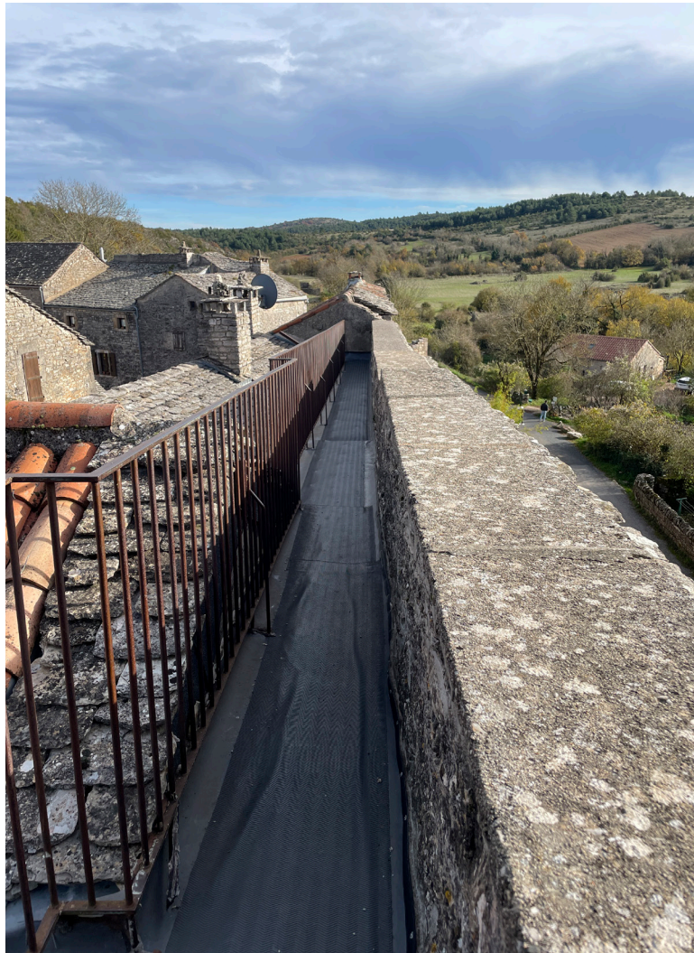
Fig. 31 : Vue du chemin de ronde de la courtine attenante à l'ouest de la porte d'Abal. Le chemin est arrêté par la présence de couvertures.
