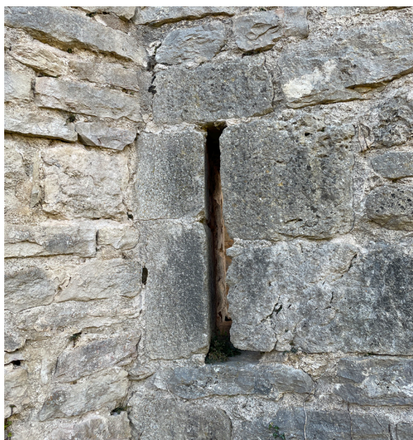
Fig. 11 : Archère à allège, en fente simple, datant de la campagne de reconstruction des années 1940.
