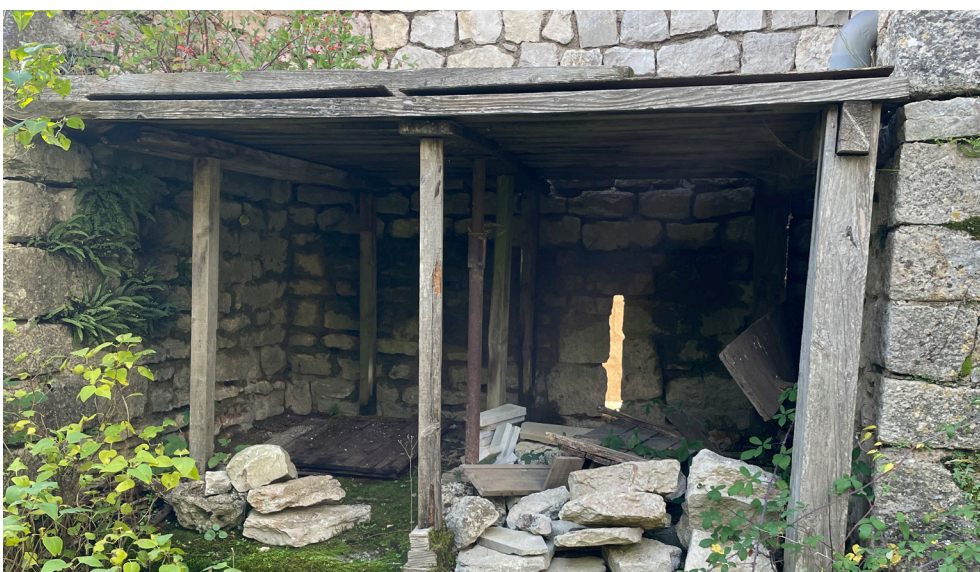
Fig. 9 : Vue de l'archère dissimulée sous la construction en bois.
