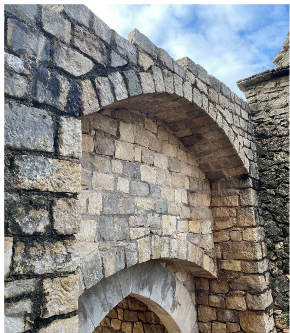
Fig. 7 : Présence de noircissements liés à une colonisation biologique.
