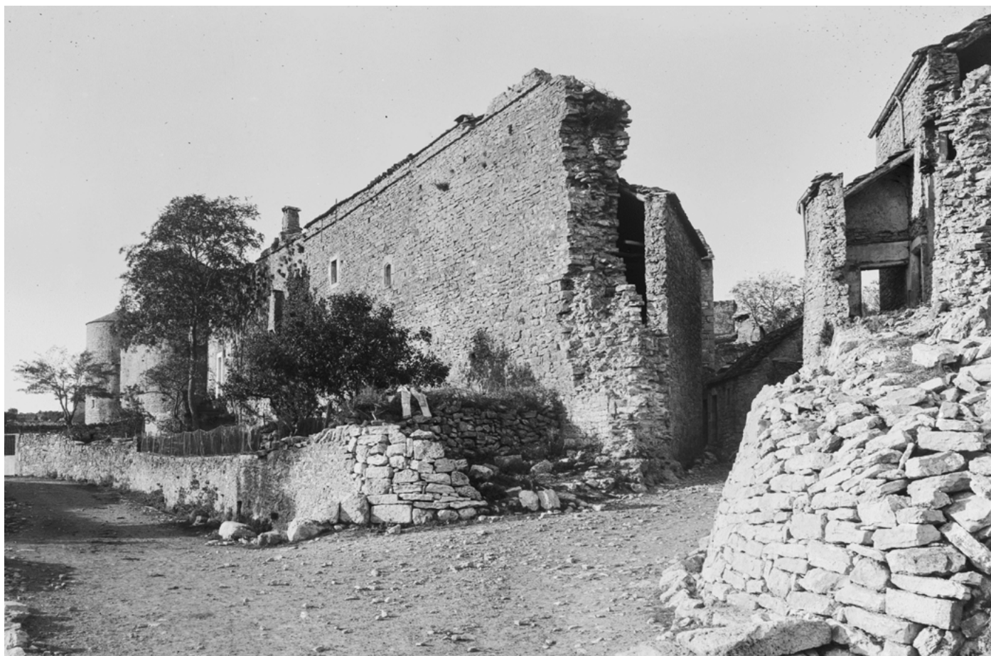
Extrait de photographie de la porte Sud après effondrement de 1912. Estève, Georges. Archives MPP - MH0085948.
