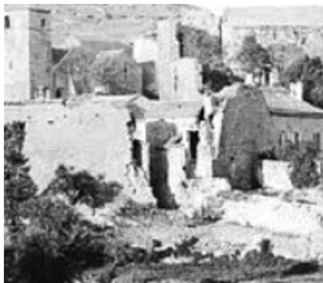
Extrait de photographie de la porte Sud après effondrement de 1912. Estève, Georges. Archives MPP - MH0076790.
