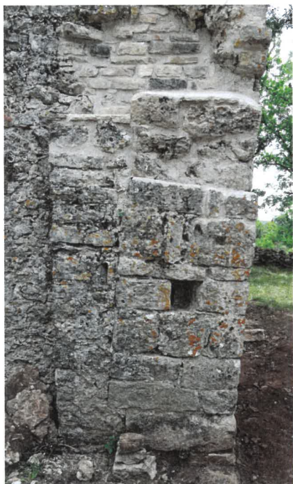
Fig. 10.53 : Salle 2, relation entre le piédroit sud de l'arc diaphragme et l'embrasure de la porte (cl. équipe).
