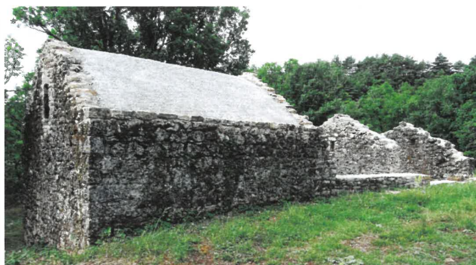
Fig. 10.8 : Vue du parement du mur gouttereau nord (cl. Chr. Saint-Pierre).
