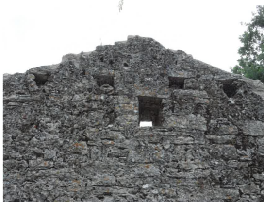
Fig. 10.50 : Salle 2, vue des trous de boulins du mur 5 (cl. équipe).
