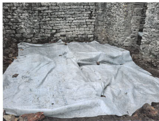
Fig. 10.90 : Mise en place du géotextile salle 2 (cl. Chr. Saint-Pierre, 14 novembre 2022).
