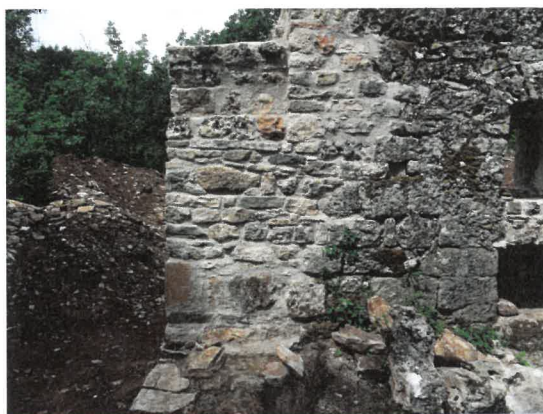
Fig. 10.54 : Salle 2, restauration de l'angle des murs 2 et 4 (cl. équipe).
