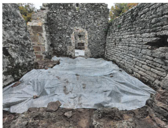
Fig. 10.89 : Mise en place du géotextile salle 1 (cl. Chr. Saint-Pierre, 14 novembre 2022).
