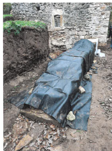
Fig. 10.88 : Protection de l'arase du mur 7 (cl. Chr. Saint-Pierre, 14 novembre 2022).
