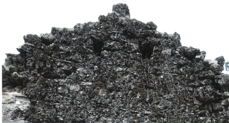
Fig. 10.51 : Salle 2, détail des trous de boulins du mur 4 (cl. équipe).
