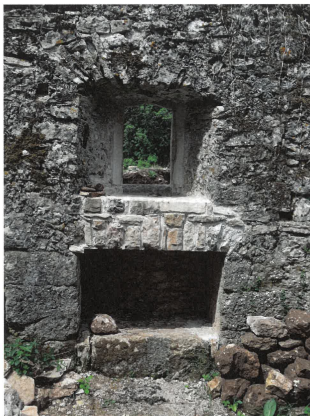
Détail des aménagements
