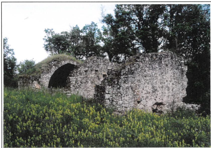
Fig. 10.4 : Clichés de l'église Saint-Christol avant restauration (cl. Association les Amis de la Couvertorade, février 2018).
