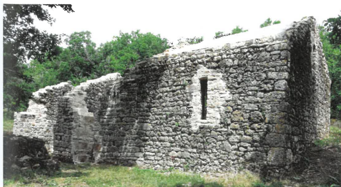
Fig. 10.7 : Vue du parement du mur gouttereau sud (cl. Chr. Saint-Pierre).
